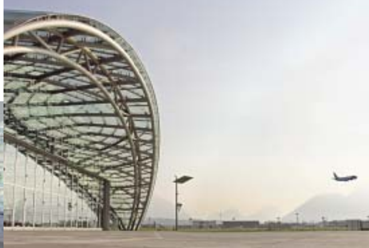
Abgehoben: Am Flughafen wölbt sich seit 2003 das aus 1754 Glastafeln konstruierte Dach des Hangar-7
